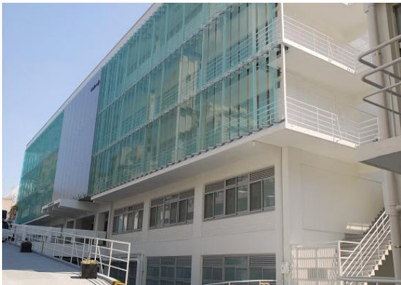
図.1 対象建物の外観
